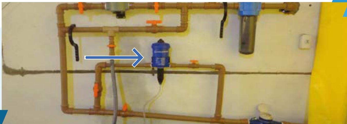
**Figura 9.** Aparato dosificador instalado en la entrada de la red hidráulica en el galpón.
